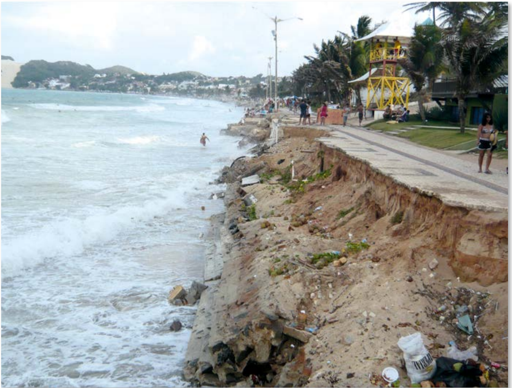
Abb. 5: Der Eingriff des Menschen in die natürliche Sanddynamik ist oft verheerend – der Zustand dieses Küstenstreifens in Ponta Negra/Natal (Nordost-Brasilien) setzt hinter diese Einsicht ein deutliches Ausrufezeichen.
