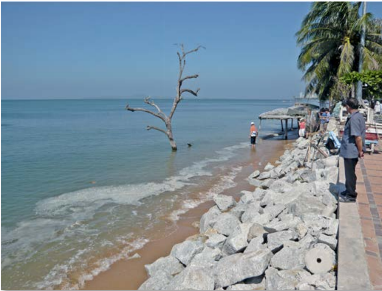
Abb. 3: Der Strand von Pattaya an der Golfküste Thailands zeigte eine von Menschenhand gefertigte Uferbefestigung. Das Ergebnis ist eine verstärkte Erosion. Ein ehemals an Land gewachsener Baum steht nun im Wasser.
