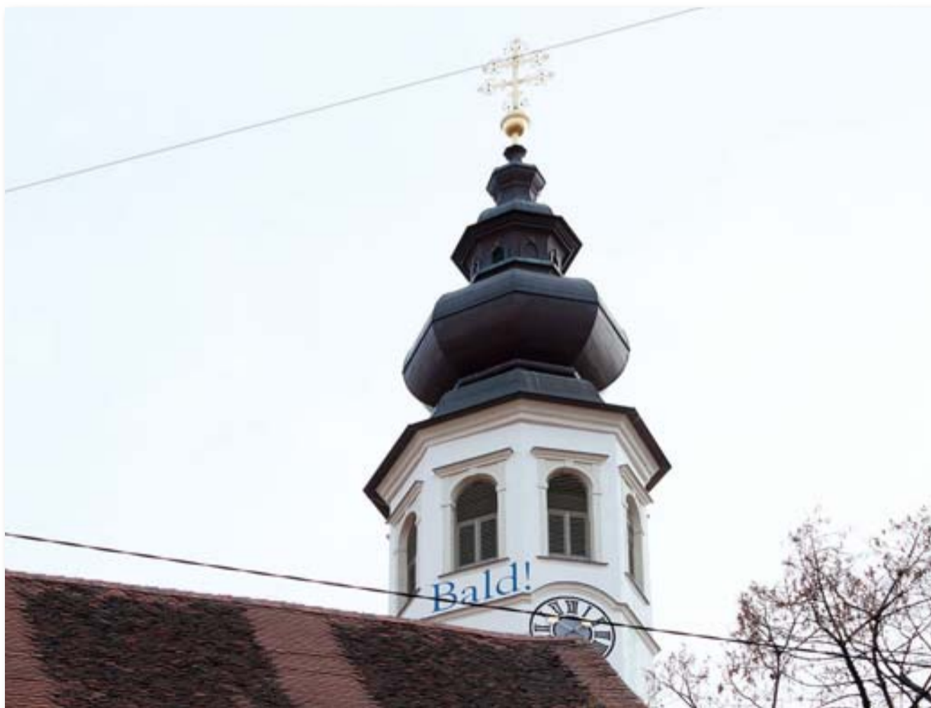
... und auch der markante Kirchturm dient als Projektionsfläche. In Kürze soll eine Website freigeschalten werden, die das gesamte Projekt von Bischof
